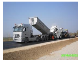
Einbau d. Asphalttragschicht
