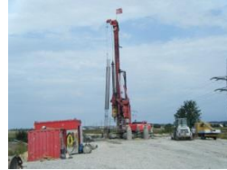
Bohrpfahlgündung BW2
