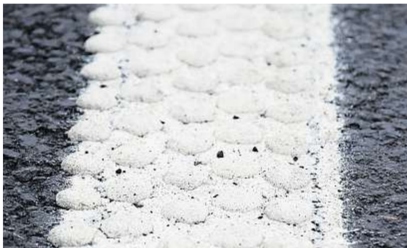
Auf der B 16 wurden Fahrbahnmarkierungen eingesetzt, die reflektieren und beim Überfahren ein akustisches Signal geben.
